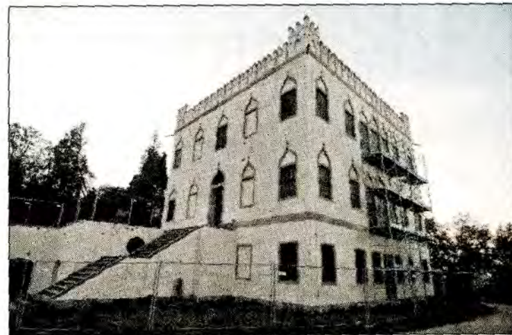
VILLA DRAGHI Polemiche sul complesso, ma presto i matrimoni
