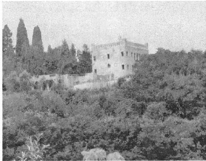
Una veduta panoramica di villa Draghi sul colle D-Day '88
